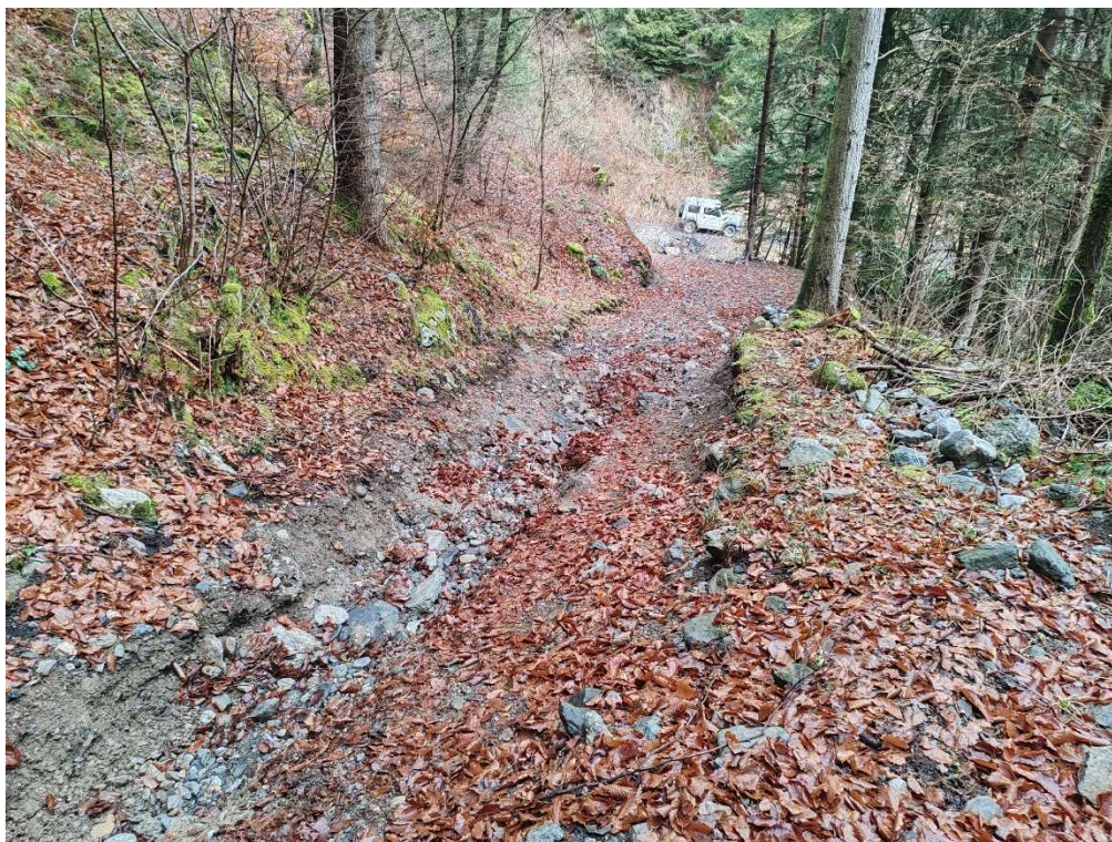
Figura 3: allargamenti, scarifica, livellamenti, selciato in pietrame e malta e canalette trasversali in profilato metallico per lo sgrondo delle acque superficiali.
