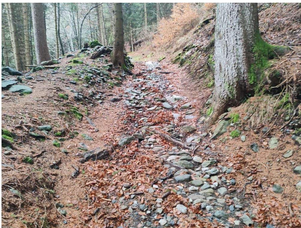
Figura 4: allargamenti, scarifica, livellamenti, selciato in pietrame e malta e canalette trasversali in profilato metallico per lo sgrondo delle acque superficiali.
