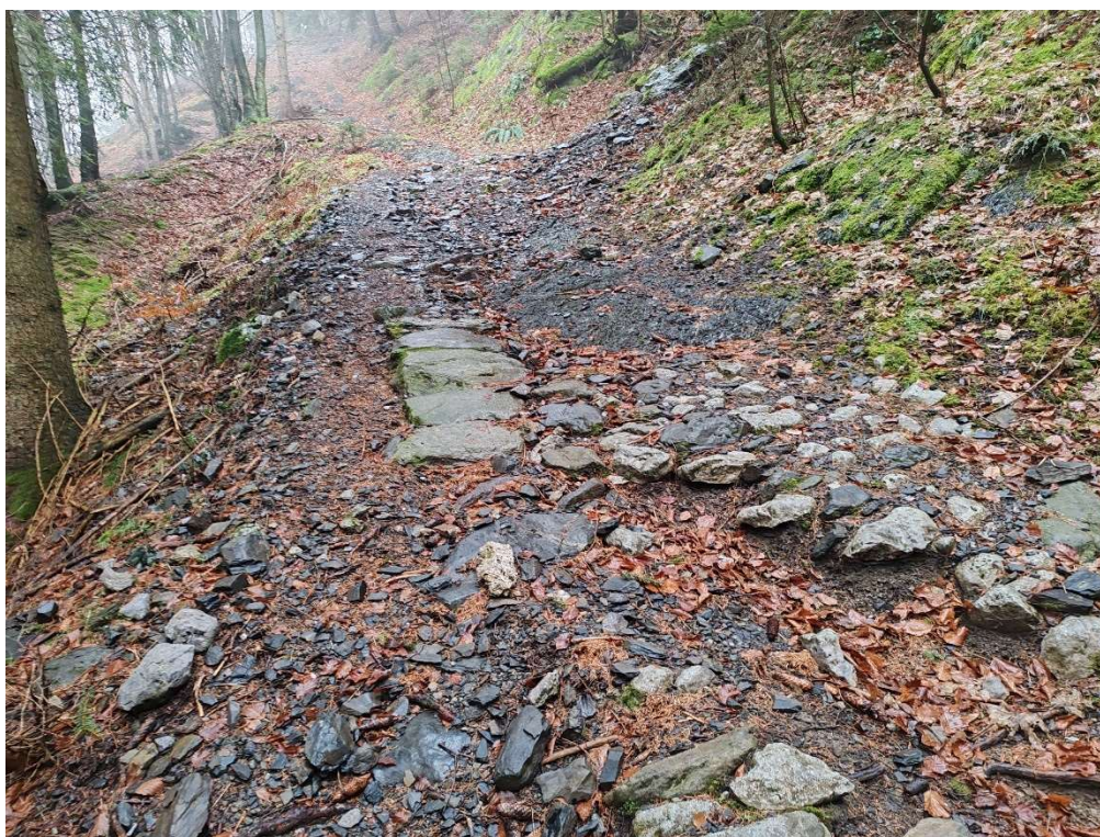
Figura 6: allargamenti, scarifica, livellamenti, selciato in pietrame e malta e canalette trasversali in profilato metallico per lo sgrondo delle acque superficiali.
