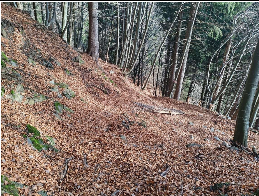
Figura 11: allargamenti, scarifica, livellamenti e staccionata in legno di castagno a protezione della caduta dell'alto.
