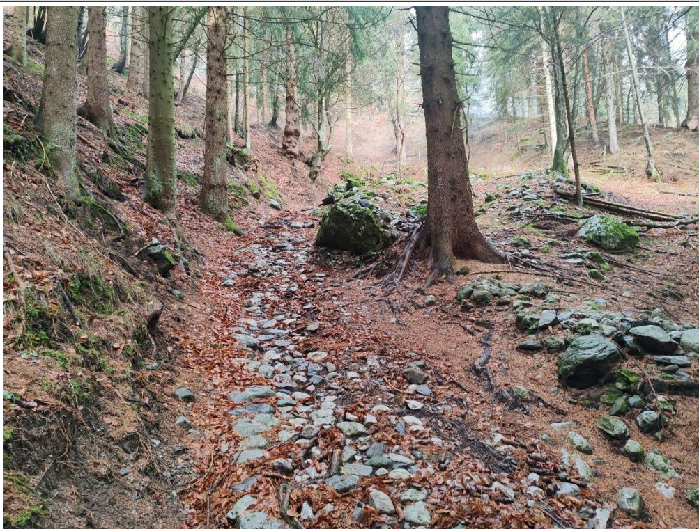
Figura 5: allargamenti, scarifica, livellamenti, selciato in pietrame e malta e canalette trasversali in profilato metallico per lo sgrondo delle acque superficiali.
